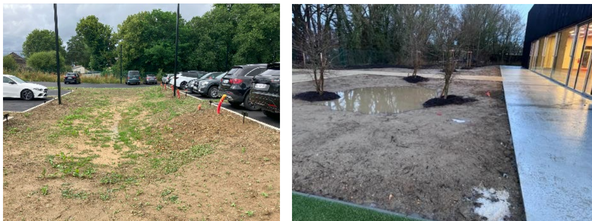
Photographie – Noue d'infiltration des eaux pluviales (2025)
